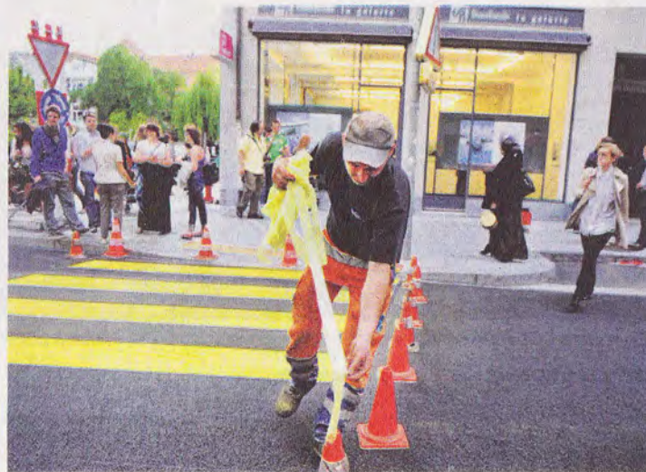
Ce n'est pas une installation! On pose un passage clouté. PIERRE ABENSUR
